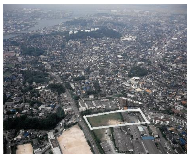
白い枠内が建設予定地
